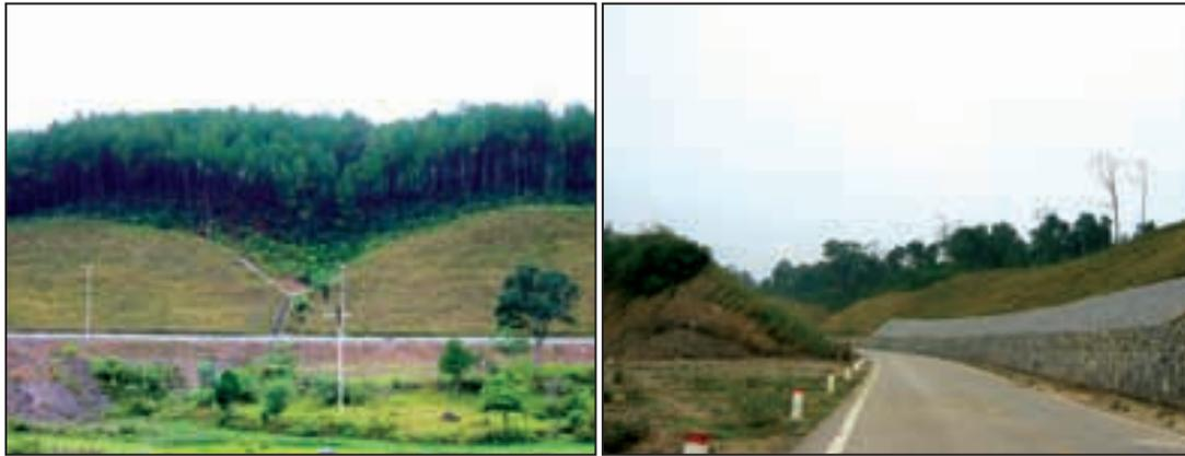
**Photo 19 : Gauche : Le vétiver stabilise des pentes coupées le long de l'autoroute de Ho Chi Minh ; droite : vétiver seul et vétiver combiné à des mesures traditionnelles**
