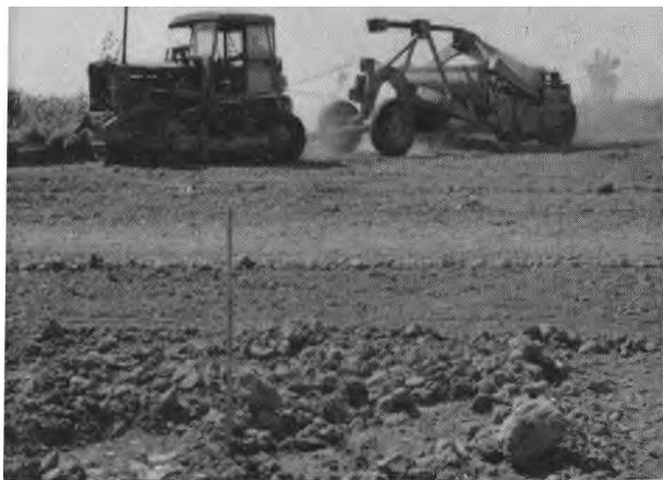
Préparation du sol avec une décapeuse (scraper) et une niveleuse (terracer).
