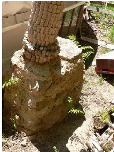
La cheminée est isolée d'un collier de bouchons en lièges, pour permettre aux fumées de ne pas trop se refroidir pendant la montée, afin de garantir un bon tirage. Le liège, au contact du tuyau, ne brûle pas vu que les fumées, en arrivant au niveau de la cheminée, ont déjà cédé la plus grande partie de leur chaleur.
