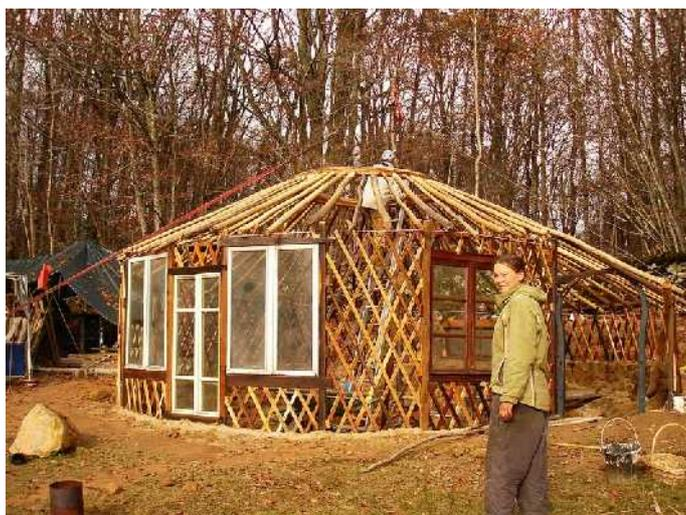
Le tonoo est descendu plus d'un côté que de l'autre ... il n'est plus horizontal ... pas de soucis, on déplace le mat de levage du côté où ça penche, on accroche un palan à chaîne en haut du mat en on relève petit à petit le côté rabaisé, puis on resserre les ficelles en bas des perches, et on relâche délicatement le tonoo ...
