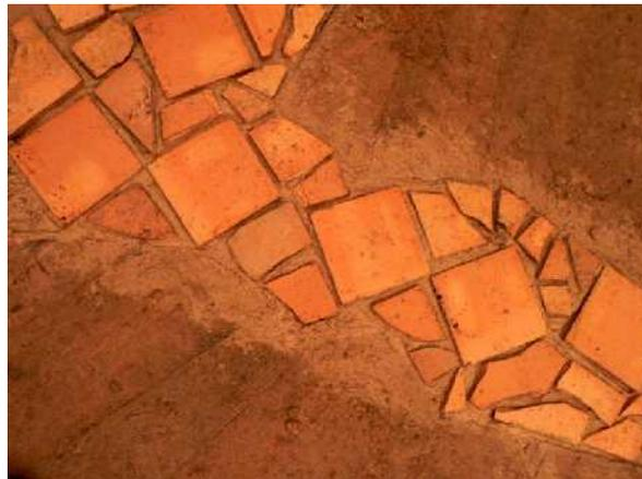
Ensuite les fumées courent dans trois tuyaux qui serpentent sous le plancher de la yourte. Ces tuyaux, qui montent légèrement tout le long de leur trajet, sont recouverts d'une épaisse couche d'argile-sable, agrémentée de vieux bouts de ferrailles en tous genres pour favoriser la conduction de la chaleur dans le mélange. En surface, des tomettes sont maçonnées à la chaux pour rejoindre le niveau du plancher ...
