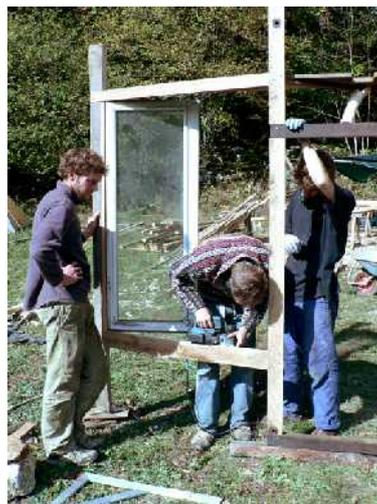
Pendant ce temps, Hugues, un ami menuisier, réalise le dormant de la porte d'entrée avec deux anciens montants de charrette ... assemblage en queue d'aronde, ciseau à bois ... du bel ouvrage. Encore faut-il ensuite réaliser une porte sur mesure ...
