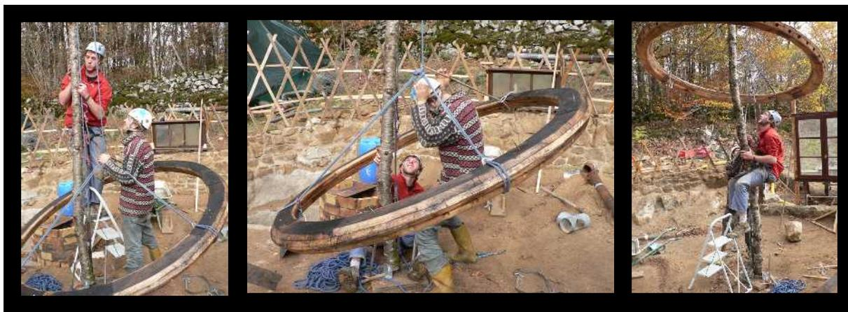
Une fois à la bonne hauteur (c'est à dire 10 à 15 cm au-dessus de sa position finale, car il va redescendre en se mettant en place) , le tonoo est stabilisé à la bonne place et ensuite, un vrai jeu d'enfant : on prend les perches une par une, on les met en place, on perce un trou en bas de la perche dans lequel on passe une ficelle qui vient se nouer autour du croisillon de treillis, et on recommence ... 54 fois dans notre cas
