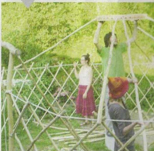
Montage des perches dans le toono, pour la petite yourte et pour la grande
