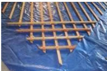
Je pose au fur et à mesure les lattes de dessus (2 par 2) en plaçant les boulons par dessous à chaque intersection. Certaines lattes sont un petit peu déformées sur la longueur et il faut les aider à trouver leur place. Je place dessus une rondelle et un boulon indesserrable (bague en nylon) juste à la main.
