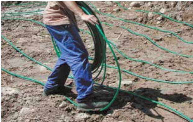
Pose de capteurs horizontaux.
