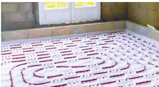
La pose d'un plancher chauffant est assez complexe en rénovation et est plus adaptée à la construction neuve.
