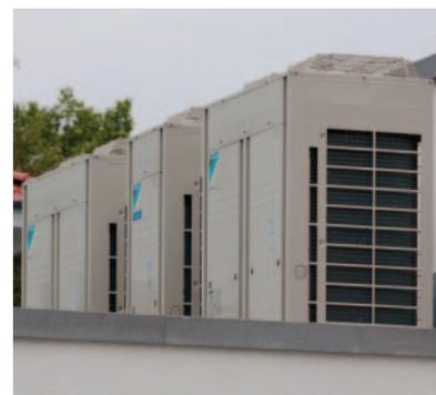
Dans un supermarché allemand, le système Conveni-Pack est combiné à un système ZEAS pour alimenter des comptoirs, des réfrigérateurs, un rideau d'air et des unités de climatisation intérieures, ainsi qu'une chambre froide et des armoires de congélation.
