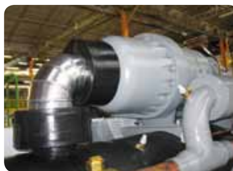
Option 257 : isolation ligne aspiration compresseur
