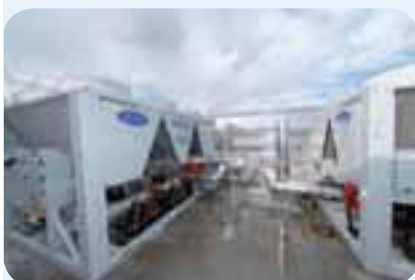
Plateforme pratique du Centre de formation.
