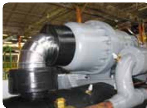
Option 257 : isolation ligne aspiration compresseur
