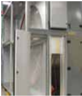
Trappes d'accès / section d'inspection
