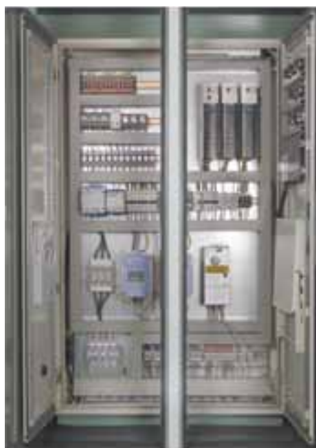
Coffret de régulation intégré
