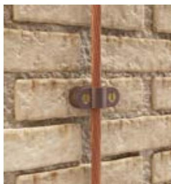
Adéquates pour la fixation de câble ou conducteur rond au bâtiment à l'aide de deux vis. Inclut chevilles et vis.
