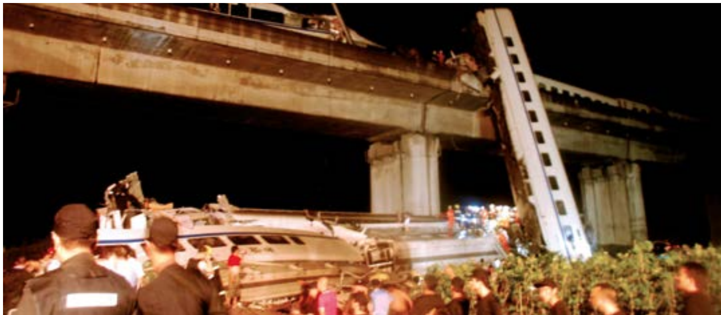
Déraillement de train dû à un impact de la foudre. Wenzhou (Chine).
