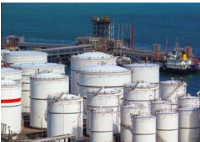
Bâtiments et entrepôts où sont manipulées ou stockées des substances dangereuses (explosives, inflammables, toxiques, etc.)
