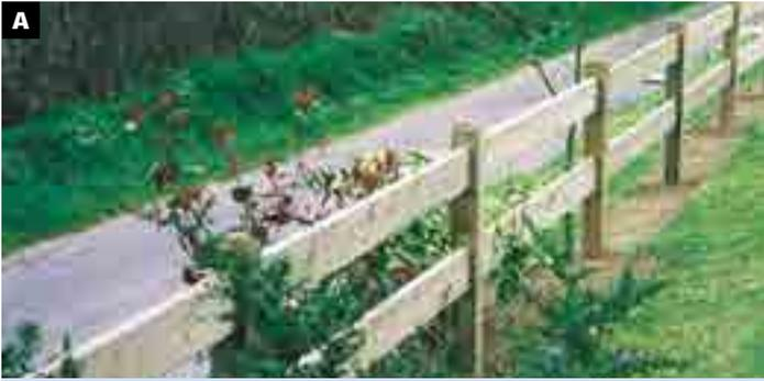
**Clôture à lisses horizontales** sur poteaux carrés 90 x 90 mm
