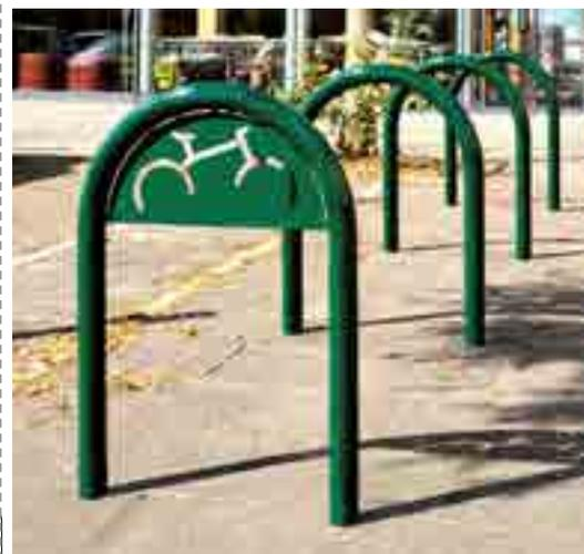
**Arceau conçu pour un parking-vélos sécurisé : maintient de la roue avant dans le support + fixation aisée de l'anti-voil au cadre du vélo**
