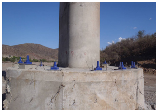
Ancrages autoforants, Pont Batopilas - Mexique
