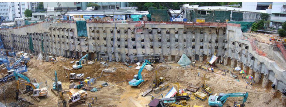
Tirants démontable SBMA - Réaménagement du centre médical Caritas Phase II - Hong Kong
