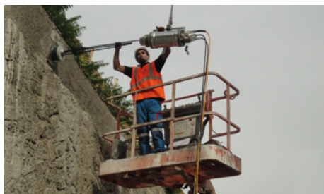
Mise en tension, tirants câbles, Rosa Parks OA9, Paris
