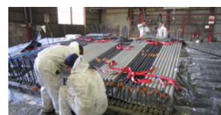
Production de tirants barre permanents
