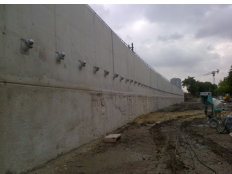
Tirants câble permanents - Gare de Rosa Parks - France
