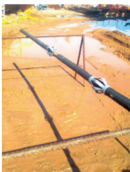
Préparation d'un tirant Freyssibar permanent - Ambassade du Canada à Rabat - Maroc
