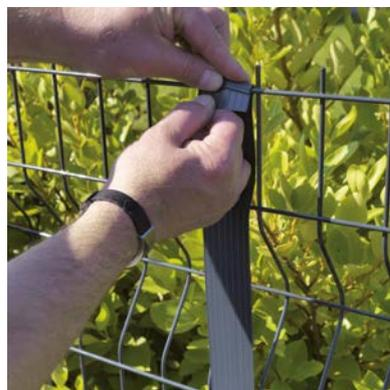
**4** - Plier la lamelle et verrouiller avec un clip.
