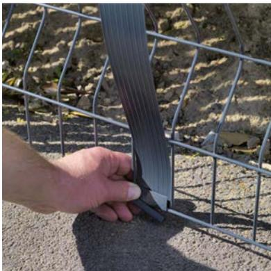
**1** - Plier une lamelle en bas du panneau puis la verrouiller avec un clip, côté plié à l'intérieur du panneau.
