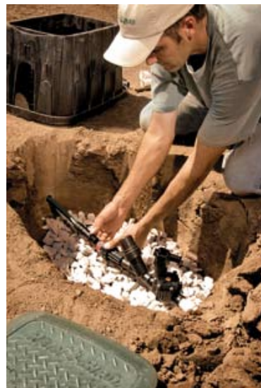
Installation d'un regard de vanne
