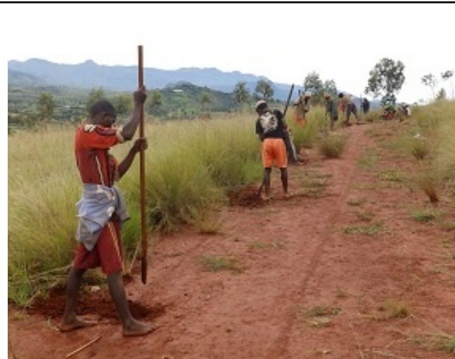
Les travaux avancent vite (© Benjamin Lisan)
