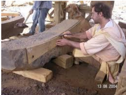
Les tailleurs de pierre de Guédelon utilisant un gabarit en bois
