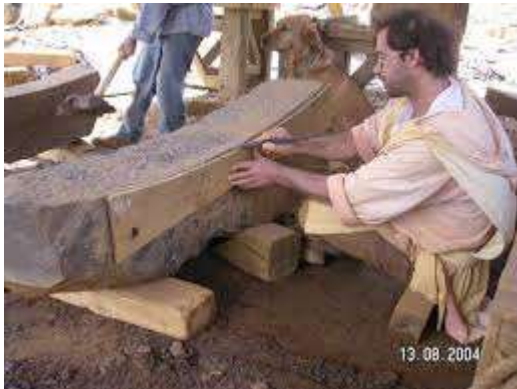
Les tailleurs de pierre du château de Guédelon, utilisant un gabarit en bois.
