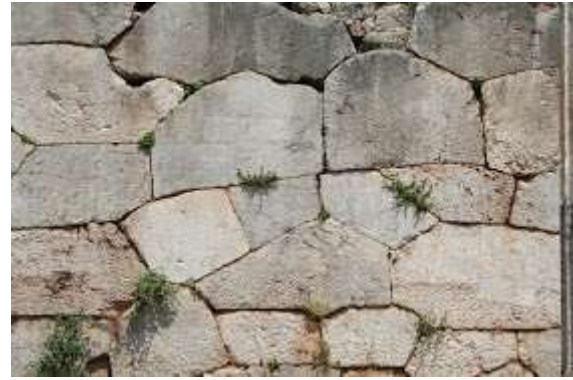
Détail du mur de soutènement de la terrasse du temple d'Apollon à Delphes. © Dominique Thillaud . Les incas n'étaient pas les seuls à construire ce type de murs, on en trouve dans le pourtour méditerranéen, par exemple.
